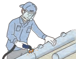
パイプの切断作業
