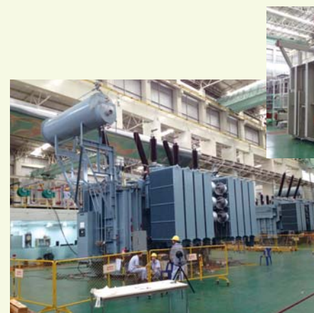
変圧器の組み立て
