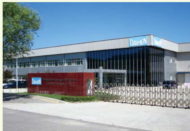
ダイヘンOTC機電北京 事業所全景
