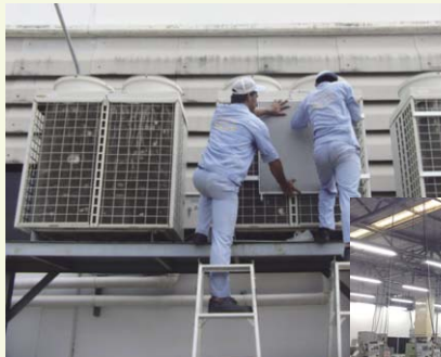
熱交換器(凝縮促進部)の設置
